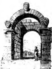
Fig. 337.—The gate of Volterra.
